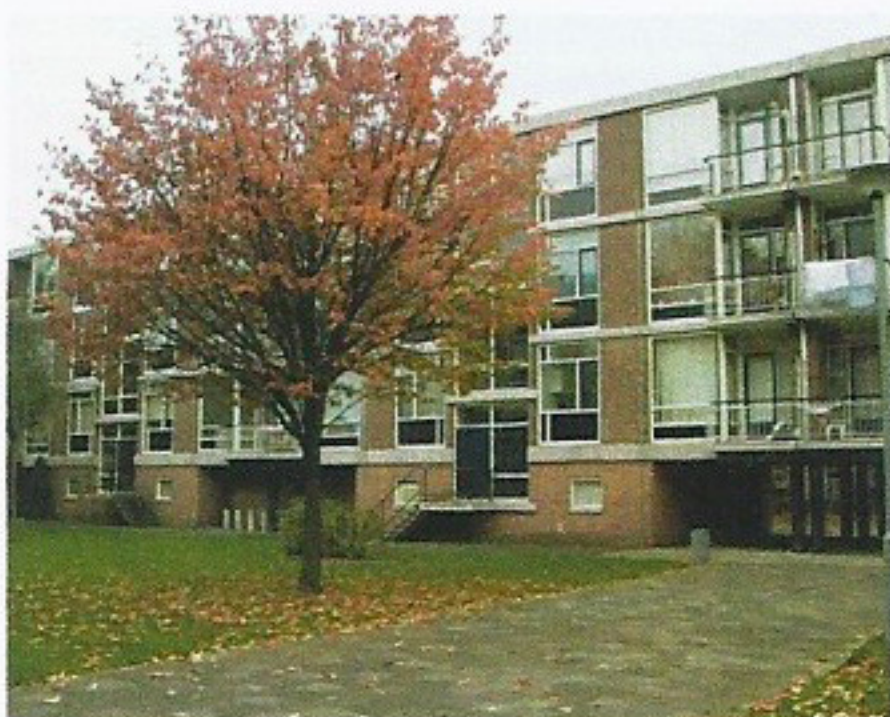
Gelaagd en plastisch: onderdoorgangen en nissen, in het vlak liggend rood metselwerk, voor het vlak geplaatste trap.
