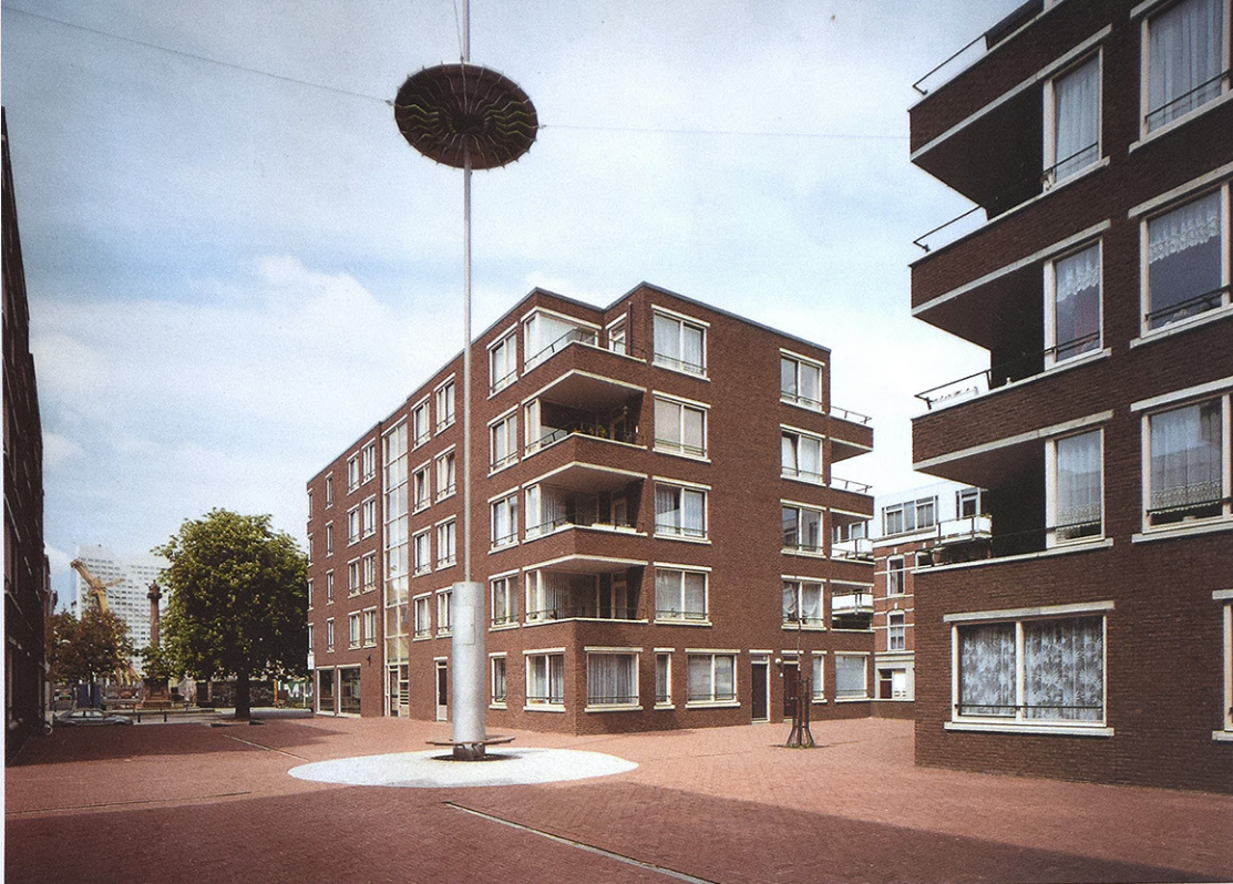
Het Lelie-blok op het Noordereiland, Rotterdam: rode straatbaksteen zorgt voor rustige tussenruimte (Architectenburo Kühne Jansen Schoonhoven)
