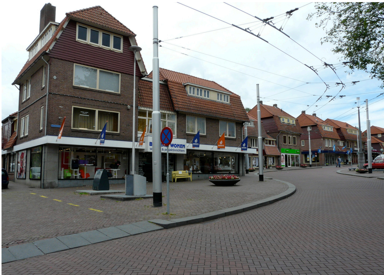
De onderzochte straatwand met op de voorgrond de winkel van Boerma in de huidige situatie.
