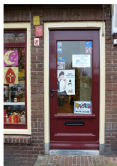
De winkel deur van Van Baal is nog oorspronkelijk, de dubbele deuren in de zijgevel van Hilvers vermoedelijk ook. Beide bevatten geen oorspronkelijk verfpakket meer.
